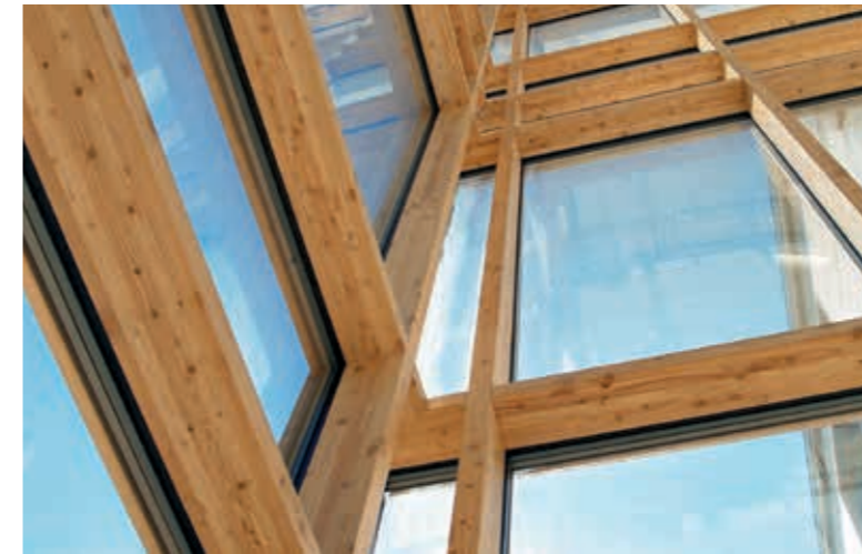
Holz-Glas Pfosten-Riegel-Fassade, Züblin Konzernzentrale Z3, Stuttgart, Deutschland
